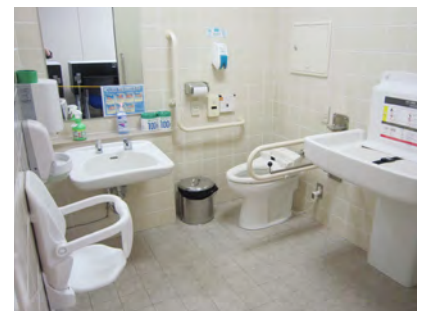
多目的トイレのベビーチェアとベビーシート
