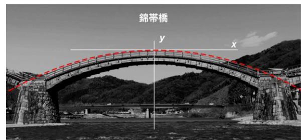
図1 根の先端と橋と鎖の形の共通性 どの輪郭もカタナリー曲線(赤点線)に一致した。
