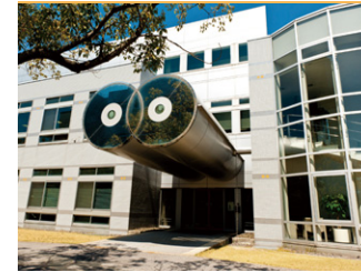
5 附属図書館(電子図書館)
