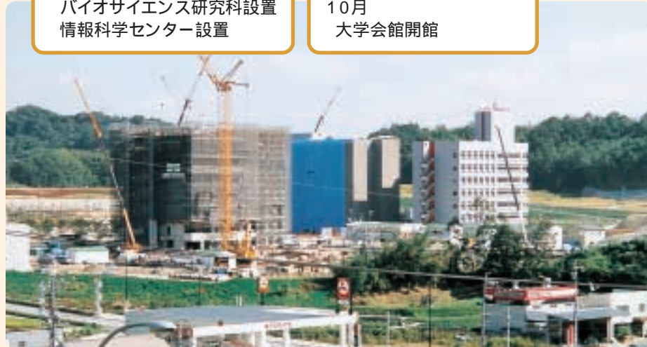
平成5年10月 工事の様子
